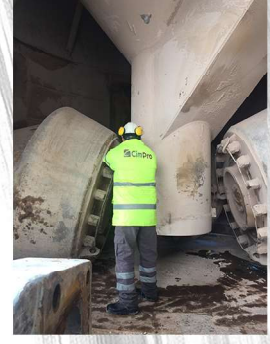
Vals Bakım Onarımı
